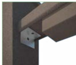
Перила крепятся к столбам при помощи металлических уголков на саморезах
